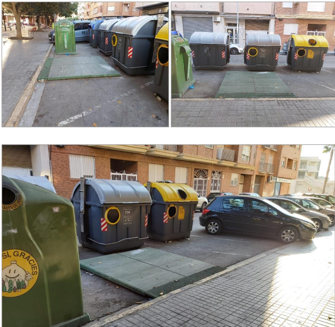
Imatge 4. Exemple de solució per a millorar l'accessibilitat als contenidors.
