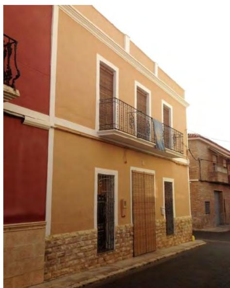
Figura 17: Vivienda en c/Corts Valencianes, 24. Huecos de la planta superior ampliados y unificados mediante balcón.
