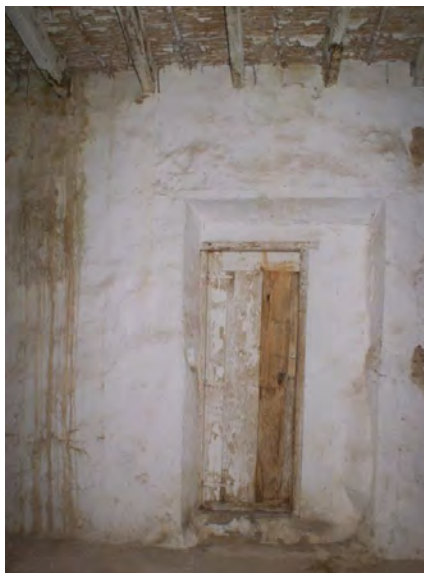
Figura 29: Vivienda en c/Mayor, 29. Muro de mampostería.
