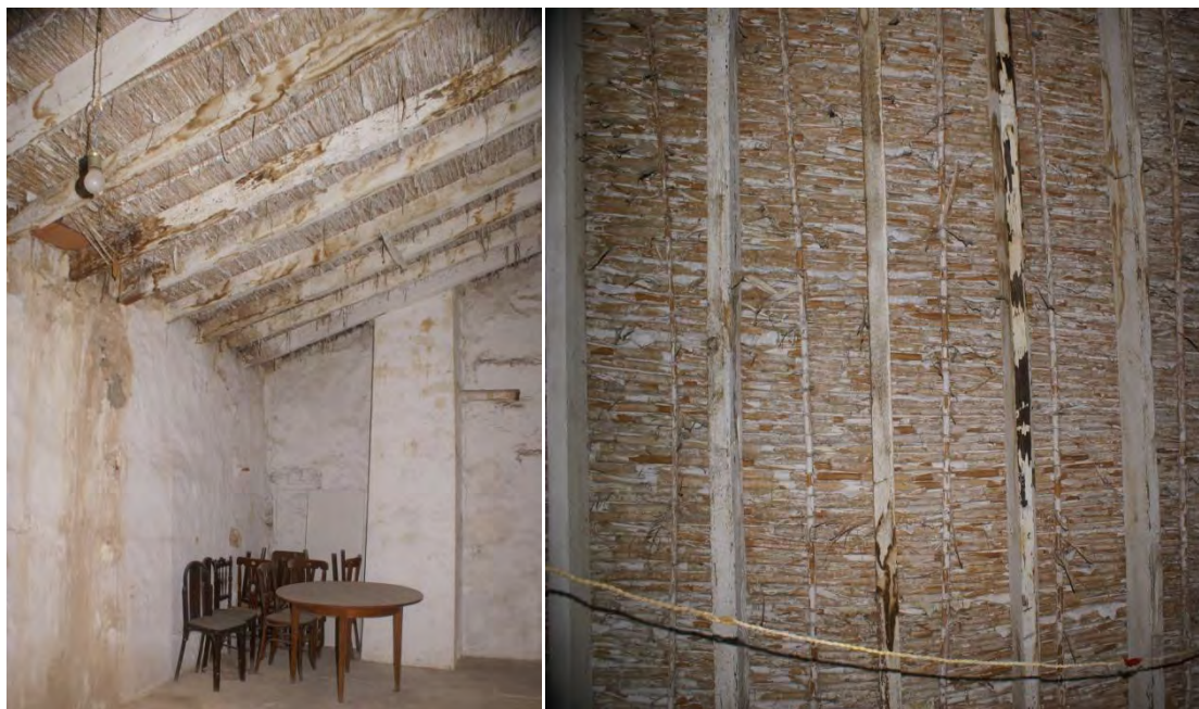
Figura 31: Vivienda en c/Mayor, 29. Cubierta inclinada a dos aguas de cañizo.
