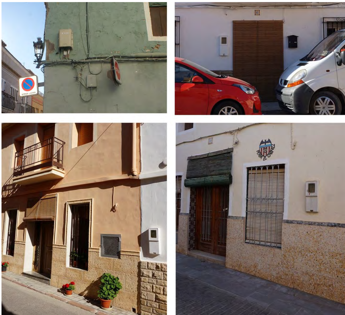
Figura 45: Ejemplos de las instalaciones fachadas en las calles de Benissanó. Arriba de izquierda a derecha; Calle Mayor 29, Plaza Gerardo 6; bajo de izquierda a derecha; Calle Corst Valencianes 32, Calle Llibertat 10.
