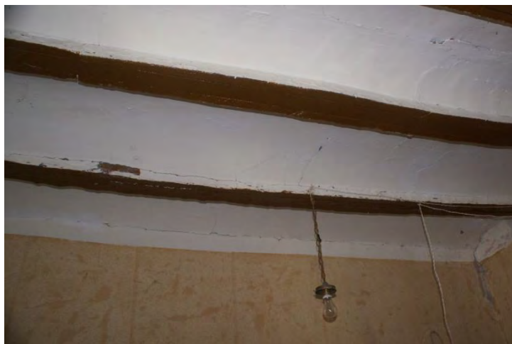
Figura 30: Detalle constructivo de forjado de revoltón de yeso con tablas o ladrillos en la c/Mayor, 29.
