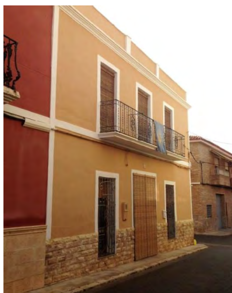
Figura 17: Vivienda en c/Corts Valencianes, 24. Huecos de la planta superior ampliados y unificados mediante balcón.
