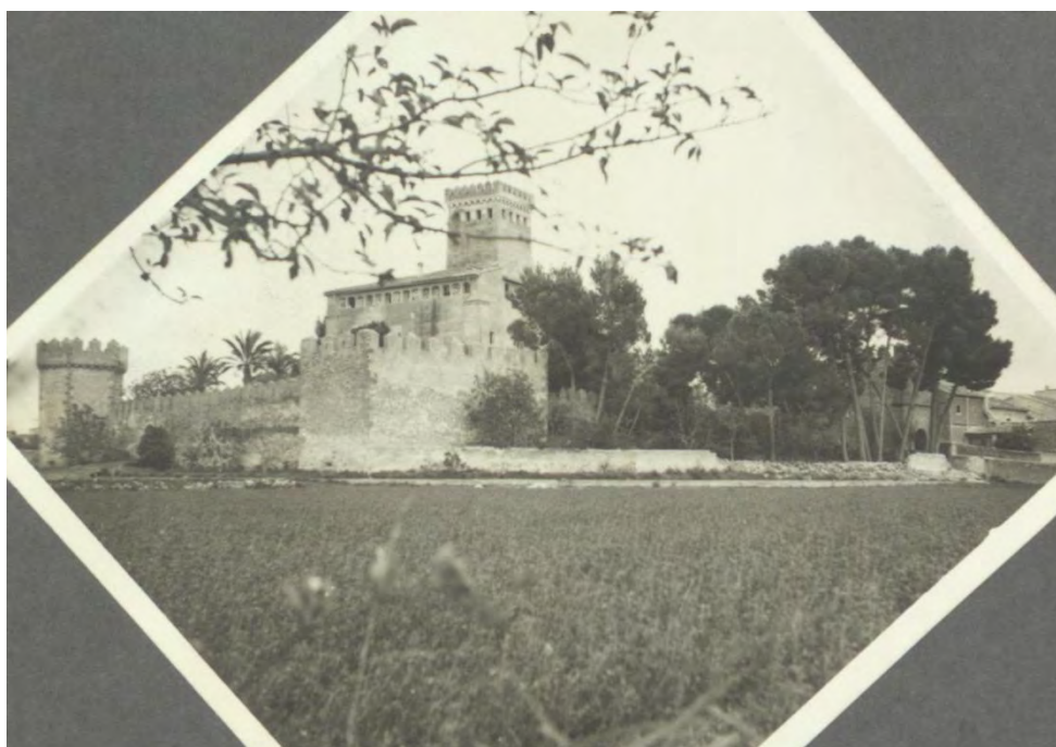
VISTA GENERAL DEL CASTILLO DE BENISSANÓ – 1958. Autor: Desconocido
