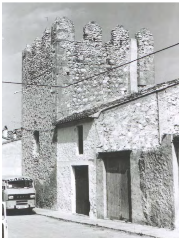
UNO DE LOS TORREONES QUE RESTAN DE LA MURALLA – 1974. Autor: Mario Guillamón Vidal
